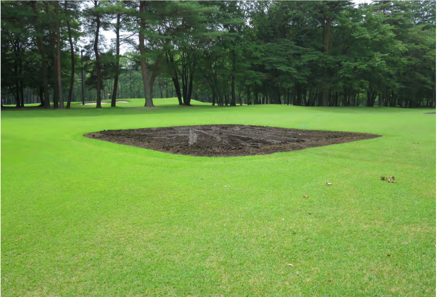
レディースティーイングエリアの造成工事（18 番）
