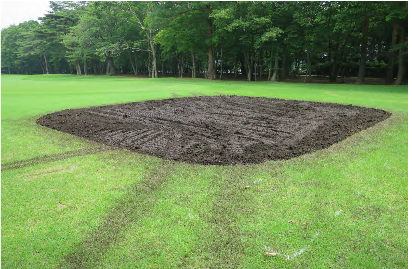
レディースティーイングエリアの造成工事（10 番）
